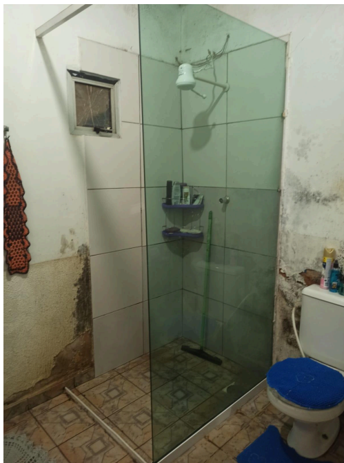
Imagem 4: Banheiro pavimento térreo
