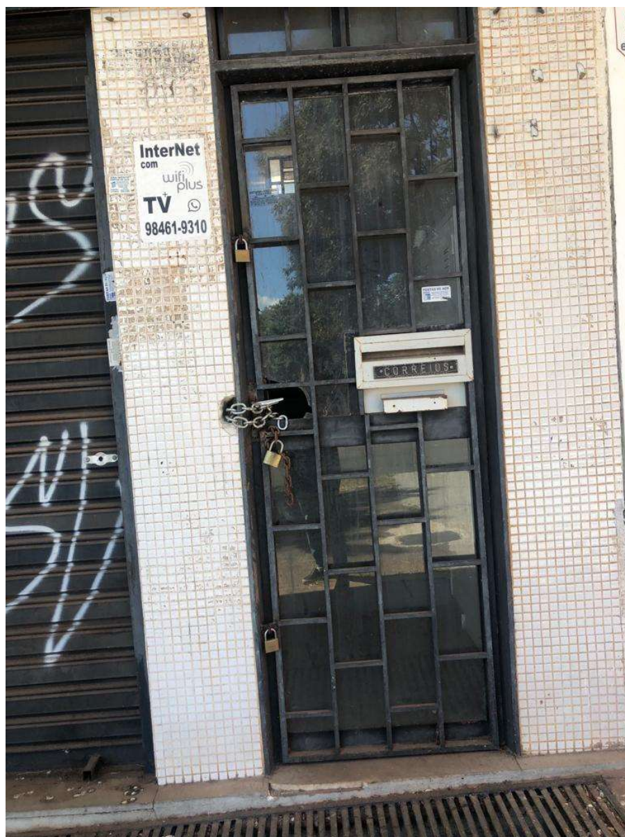
Foto 4 – Entrada para Sobreloja fechada com cadeado
