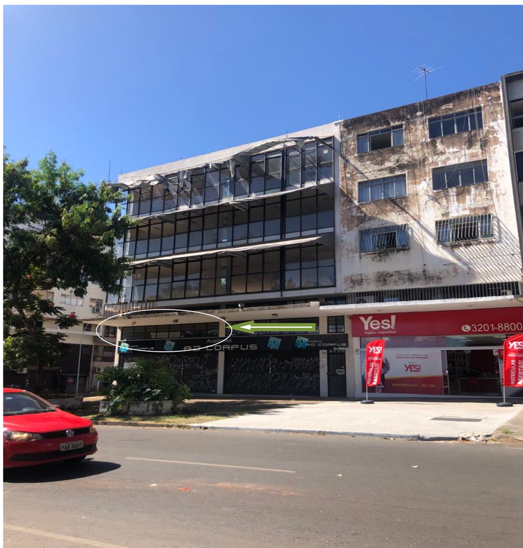
Foto 2 – Fachada do Prédio
